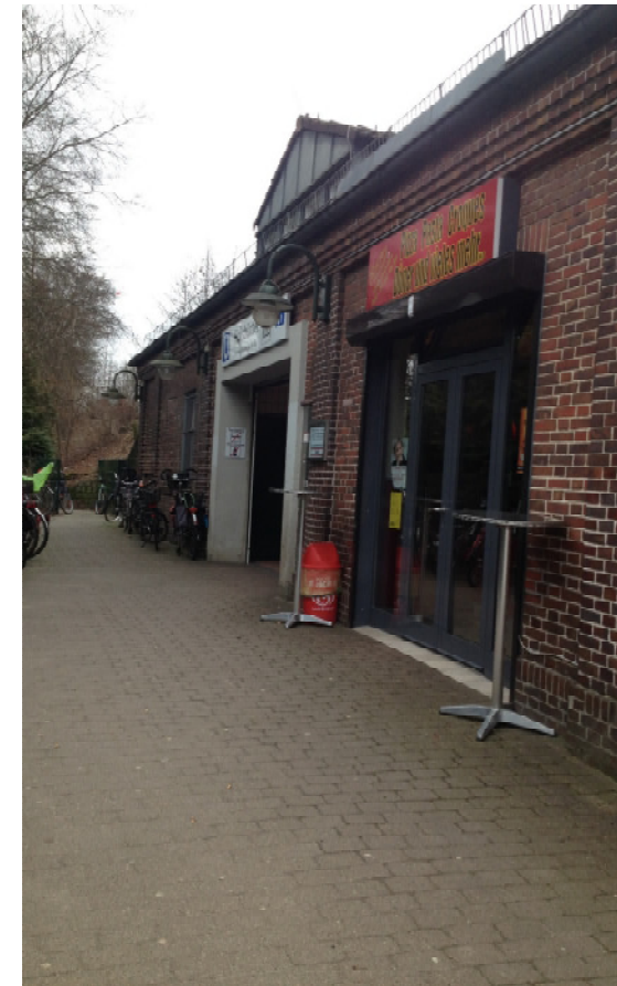
U- Bahn Hoisbüttel
