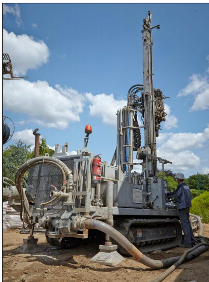
Abbildung 6: Geothermiebohrung mittels Raupenbohrgerät
