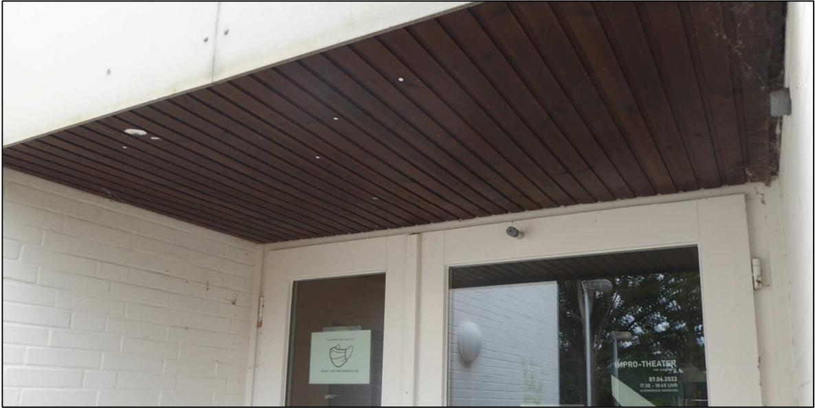
**Abbildung 4: Dachüberstand an den Eingängen. Völlig abgedichtete Konstruktion (31.07.2022).**
