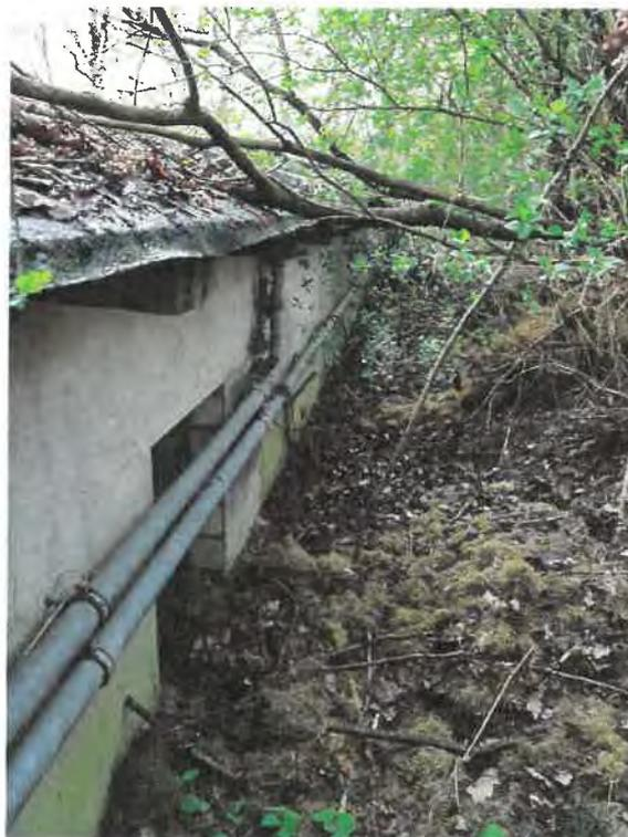
**Foto 8 Heizöl-Zuleitungen im Böschungsbereich hinter Halle Produktion/Verladung**
