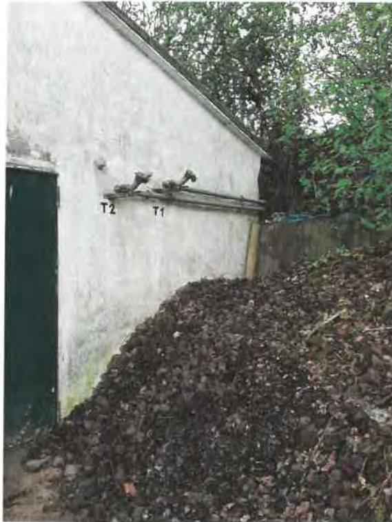
**Foto 7 Heizöl-Befüllstutzen und -Zuleitungen im Bereich der Halle (Produktion/Verladung)**
