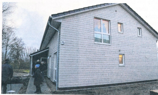
In nur drei Monaten sind die beiden Gebäude fertig geworden.
