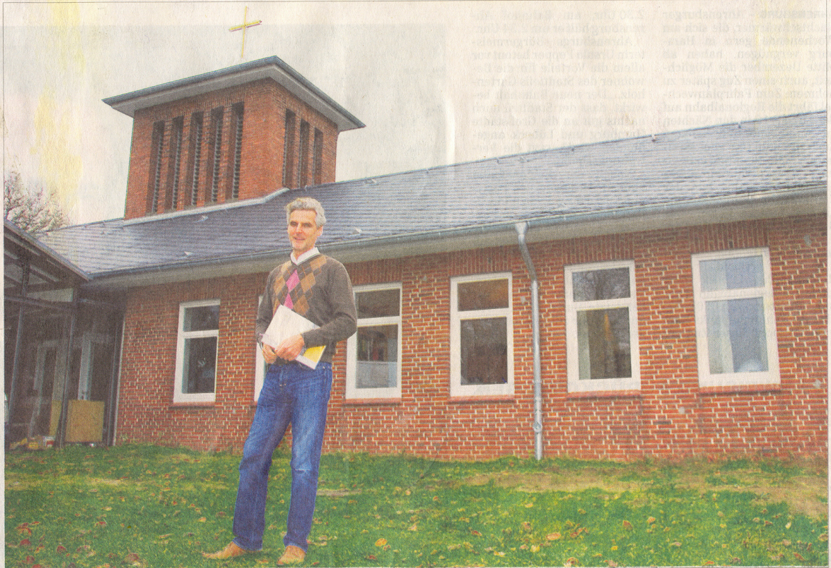
Das Haus am Schüberg erstrahlt in neuem Glanz. Geschäftsführer Heiner Witte freut sich, dass die Umbauarbeiten abgeschlossen sind. FOTOS: DIETRICH
